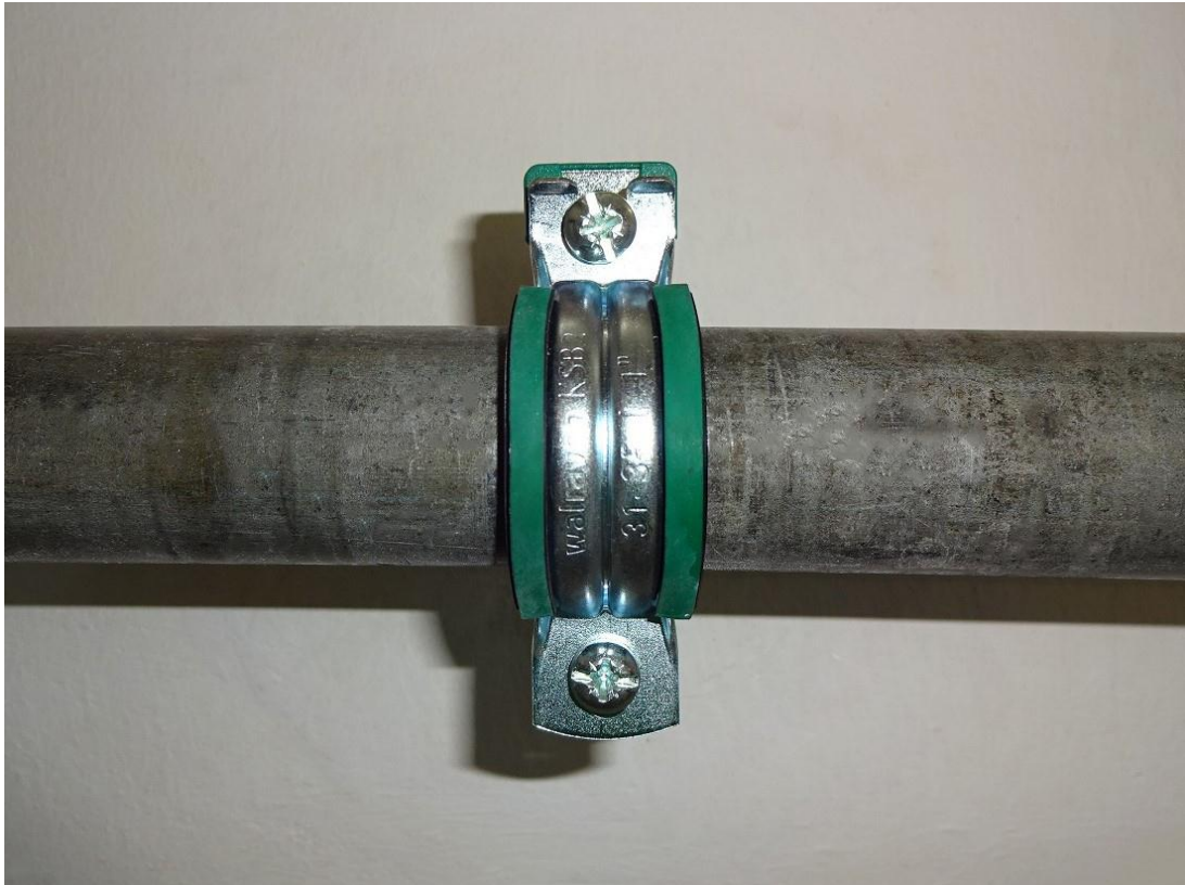
Bild 1: Messung 2: KSB2 Zweischrauben-Rohrschelle, 1" (31 - 35 mm), mit EPDM-Einlage (20 x 3,70 mm)
